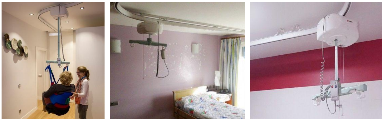
Fig. 37: Grúa de techo con motor, carril, motor y soporte de arnés.
