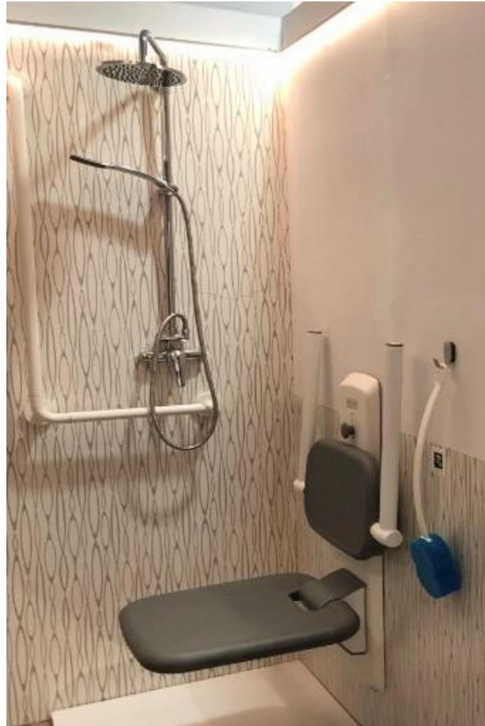
Ilustración 7 Asiento de ducha abatible y barras en ángulo recto.
