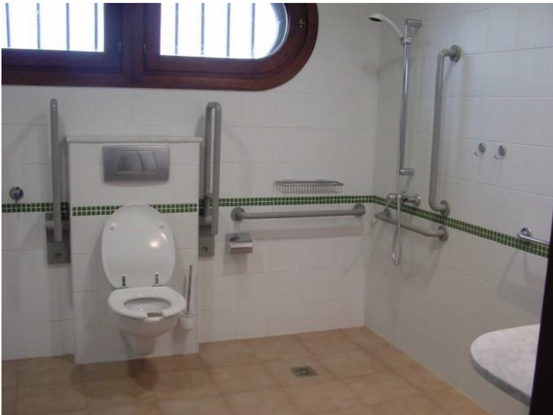
Ilustración 8 Ubicación y equipamiento de inodoro y ducha.
