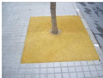
*Ilustración 4. Ejemplo de alcorque correctamente cubierto.*
