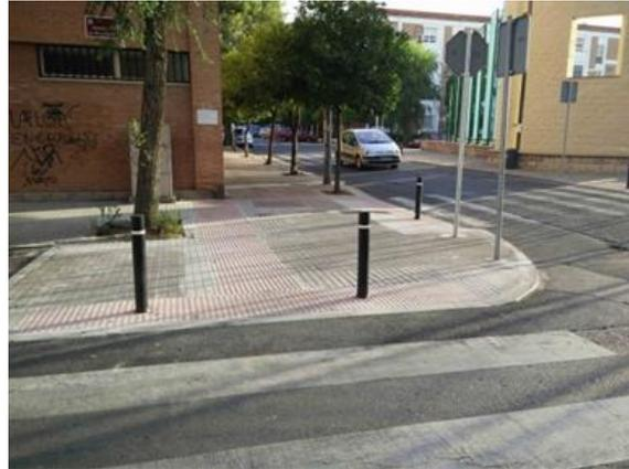
*Ilustración 2 Paso peatonal elevado con pavimento táctil y bolardos separados correctamente.*
