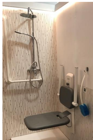
Ilustración 8 Asiento de ducha abatible y barras en ángulo recto.
