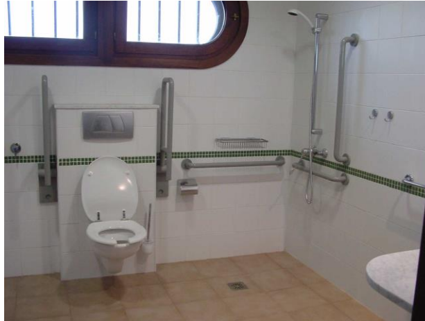
Ilustración 10 Ubicación y equipamiento de inodoro y ducha.
